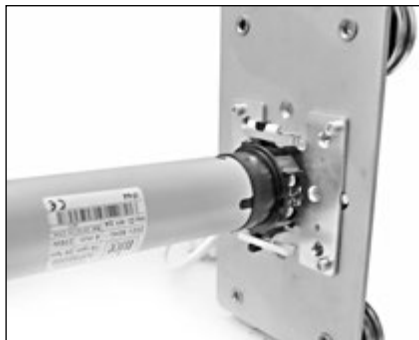
Рис.3.6 Установка двигателей "Nice" серий Neo M, Neo Star, Neo Mat и Sun с использованием крепления KM/M100.
